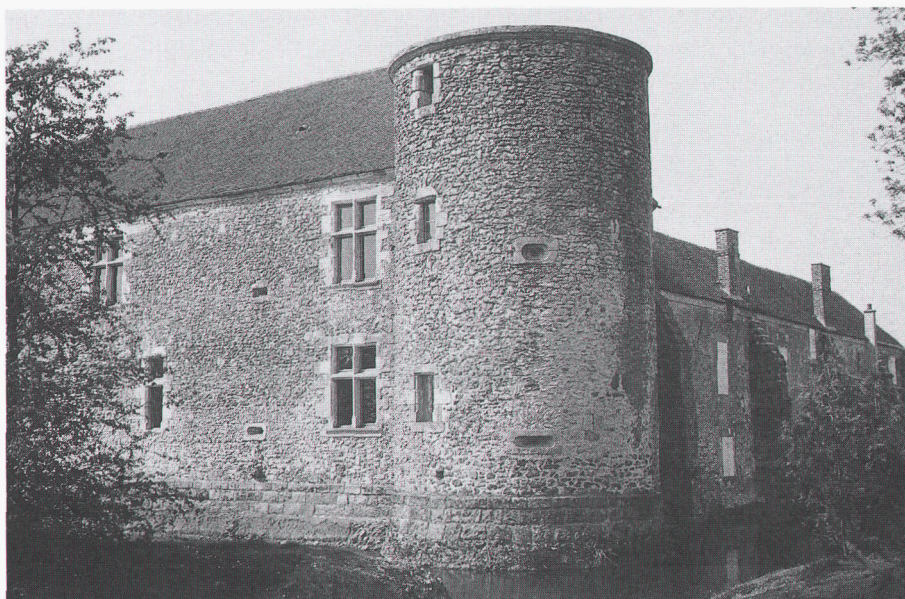
Fig 10 : Verdelot (Seine-et-Marne), maison forte de Launoy-Renault : détail d'une tour d'angle de l'aile du logis (cliché C. Corvisier). On remarque les canonnières pour la couleuvrine (milieu XVI e siècle), voisinant avec des trous à mousquets reperçés (fin XVI e -début XVII e siècle).
